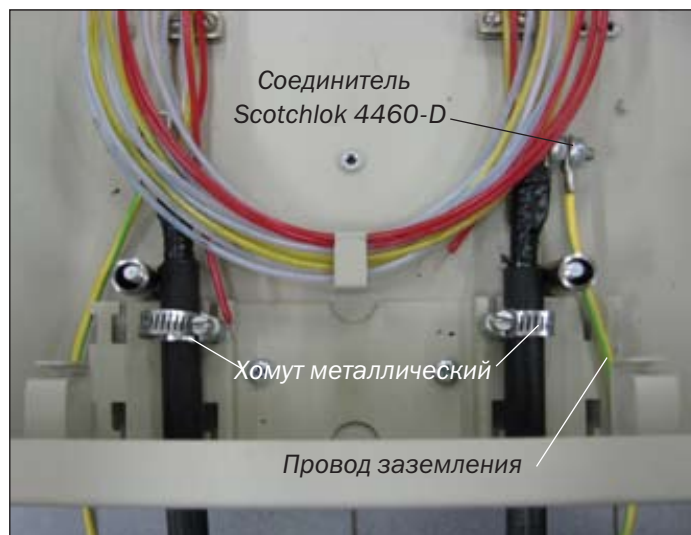
Рисунок 5.5 – Укладка “транзитных” петель ОМ внутри шкафа
