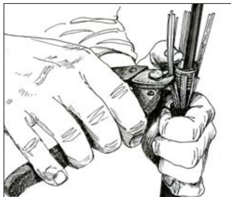
Рисунок 4.5 - Обрезка лишних длин проволок бронепокрова
