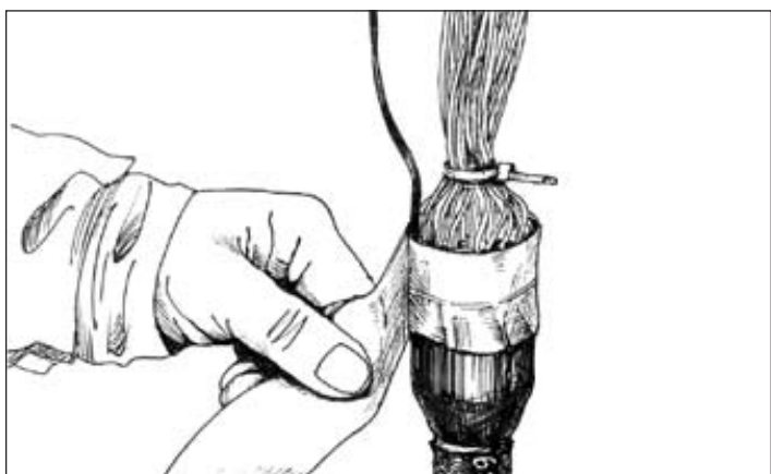
Рис. 3.7 - Наматка липкой ленты на корпус муфты
