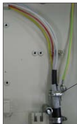
Рисунок 5.2 - Крепление ОК с бронепокровом из проволоки, с использованием КЗОК-1
