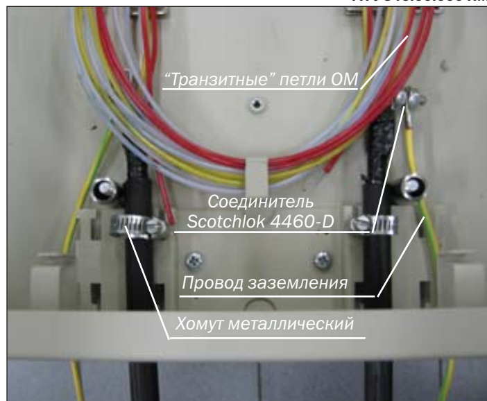
Рисунок 5.4 – Укладка “транзитных” петель ОК внутри шкафа
