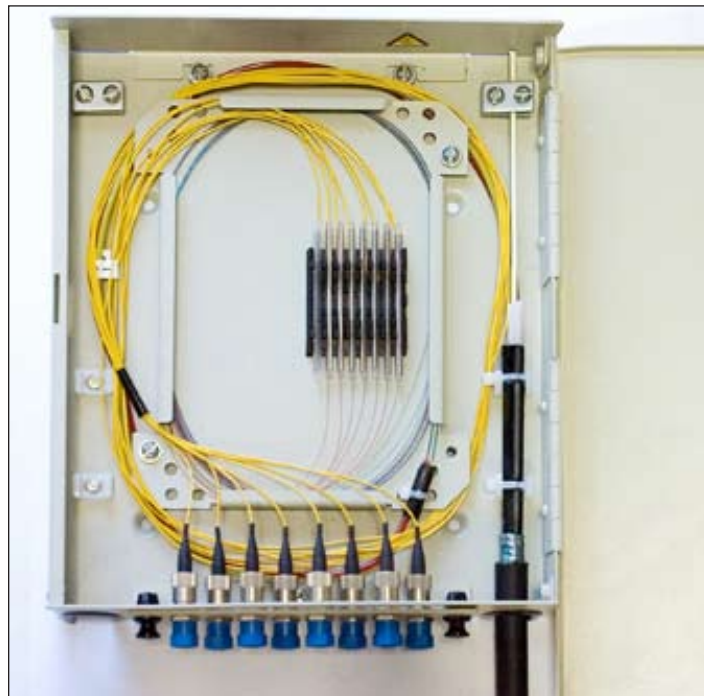
Рисунок 5.2 – Расположение запасов длин запасов ОМ, ОВ и pigtail после монтажа
