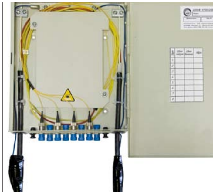
Рисунок 5.4 – Смонтированный шкаф с транзитным ОМ и установленным комплектом заземления
