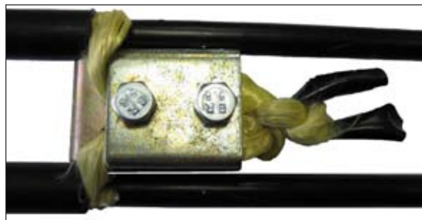
Рисунок 4.43 – Крепление нитей
