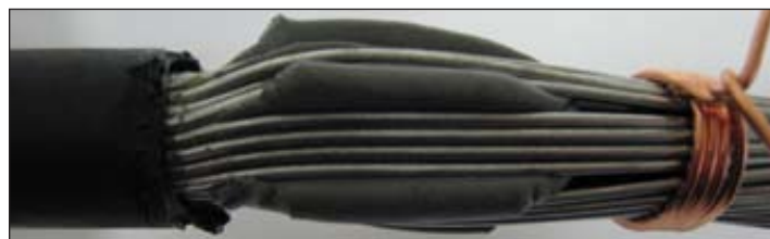
Рисунок 4.35 – Наложение бандажа из проволоки
