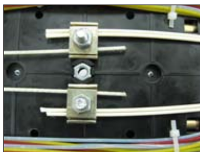
Рисунок 4.46 – Крепление ЦСЭ
