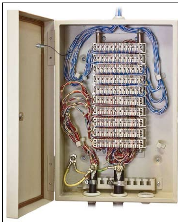
Рисунок 4.5 – Смонтированный шкаф ШРН-В/100-С
