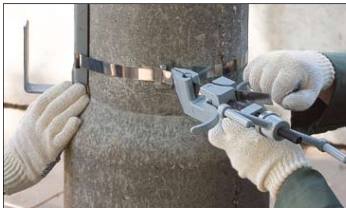
Рис. 4.5. Обрезка ленты с помощью клещей натяжных
