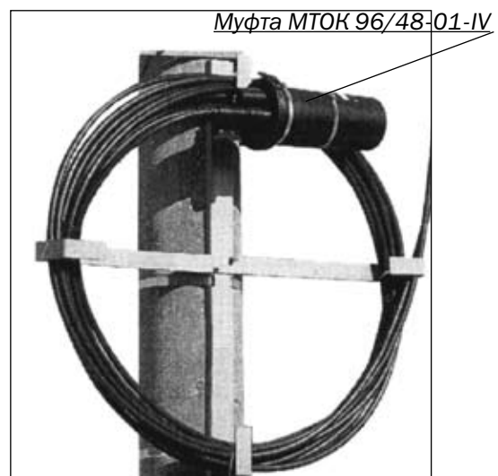
Рис. 5.2. Устройство УПМК с разными муфтами
