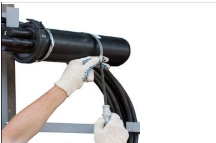
Рис. 5.1. Крепление муфты к кронштейну хомутами
