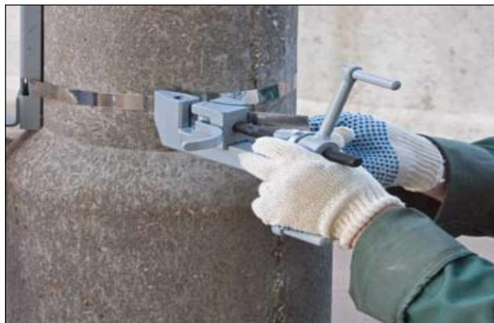
Рис. 4.4. Натяжение ленты с помощью клещей
