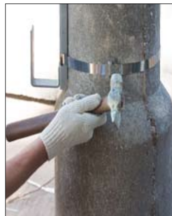
Рис. 4.7. Забивание зажимов к столбу замка-фиксатора
