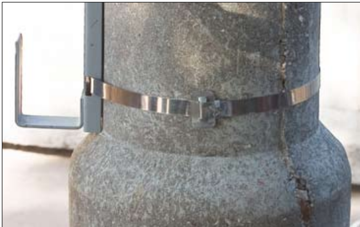
Рис. 4.8. Вариант крепления УПМК монтажной лентой с помощью замка-фиксатора.
