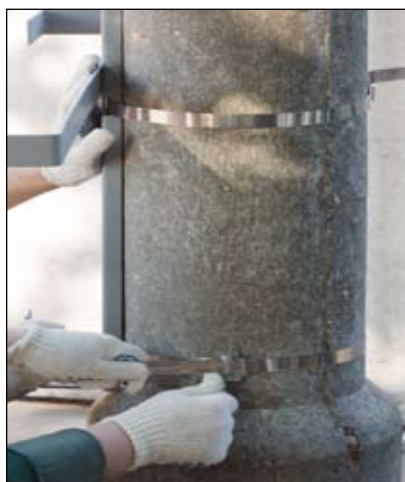
Рис. 4.2. Отрезка длины монтажной ленты с помощью клещей натяжных
