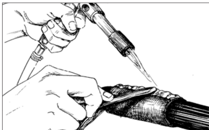
Рис. 3.4 - Запайка продольного разреза свинцовой втулки
