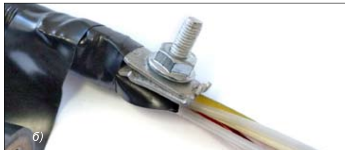
Рисунок 4.6 – Установка соединителя Scotchlok 4460-D
