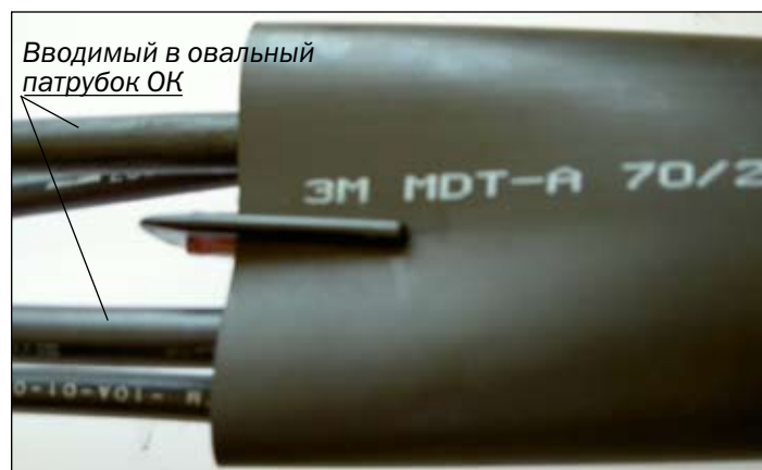
Рисунок 4.12 – Установка разветвительного зажима
