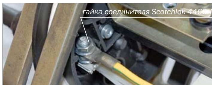
Рисунок 5.1 – Размещение соединителя Scotchlok 4460-D с установленным проводом электрического соединения (перемычкой) в оголовнике муфты
