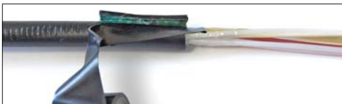
Рисунок 4.4 – Конец ленты 88Т, подложенный под отогнутый участок оболочки
