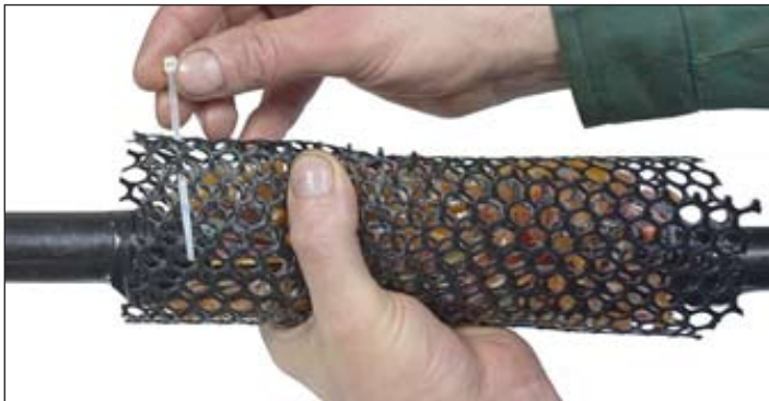
Рисунок 3.5 – Установка сетки на сросток и крепление стяжками
