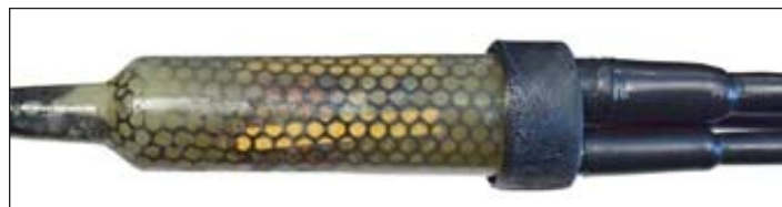
Рисунок 4.5 – Сросток сердечника разветвительной муфты после демонтажа корпуса (полумуфты)
