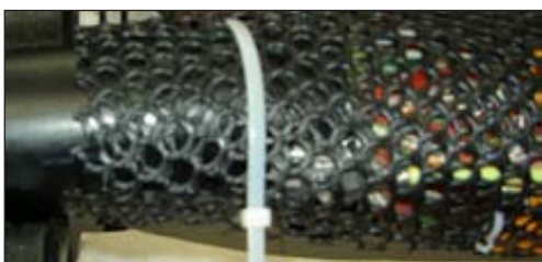
Рисунок 3.6 – Скрепленная на сростке сетка
