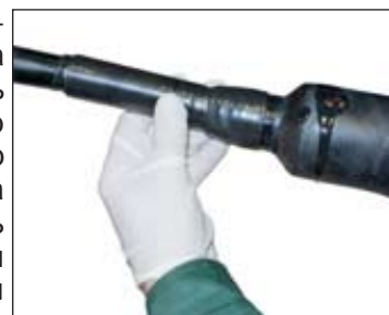
Рисунок 3.15 – Выпуск воздуха из корпуса муфты
