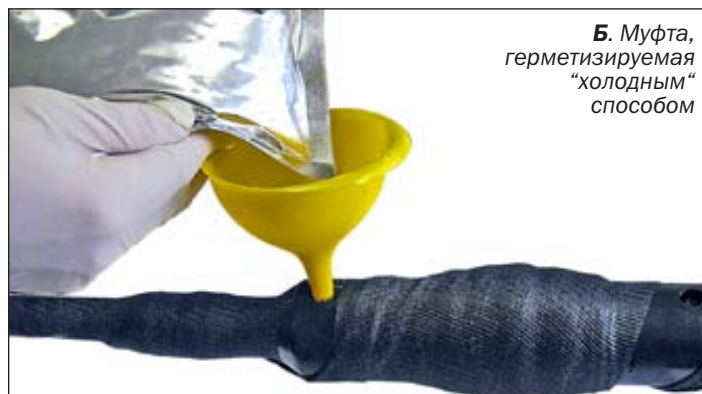
Рисунок 3.14 – Заливка герметика в муфты
