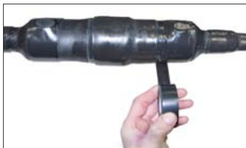
Рисунок 3.18 – Наложение ленты 88Т поверх ленты VM
