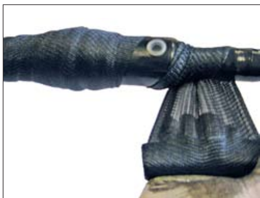
Рисунок 3.12 – Намотка бинта Армопласта (Armorcast)
