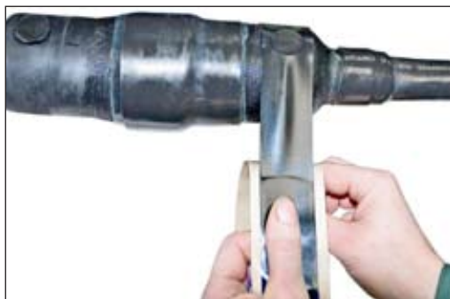
Рисунок 3.17 – Наложение ленты VM поверх пробок
