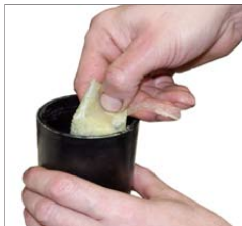
Рисунок 3.1 – Смазка внутренних поверхностей корпусов муфты гидрофобным наполнителем кабеля
