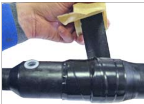
Рисунок 3.10 - Намотка ленты VM на стыке корпусов муфты
