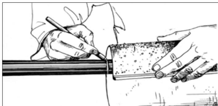
Рисунок 4.3 - Отметка места на оболочке кабеля, где заканчивается манжета
