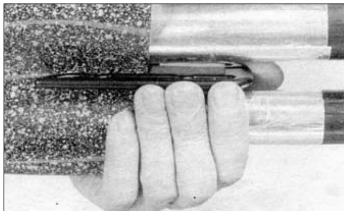
Рисунок 4.15 - Установка разветвительного зажима (2 ответвляющихся кабеля)
