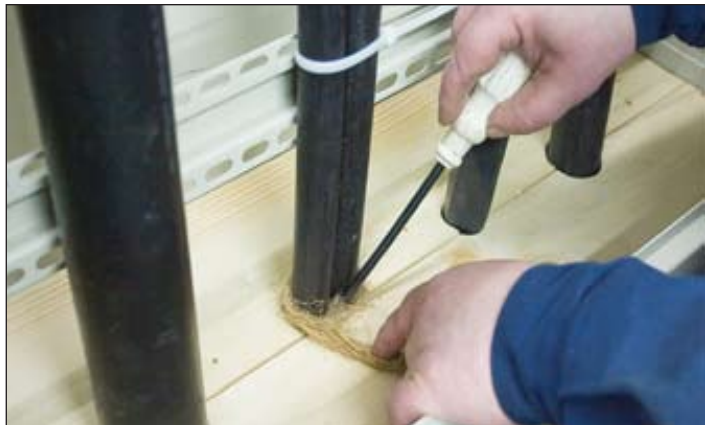
Рисунок 3.1 – Заделка отверстий между шкафной доской и вводимыми в шкаф кабелями
