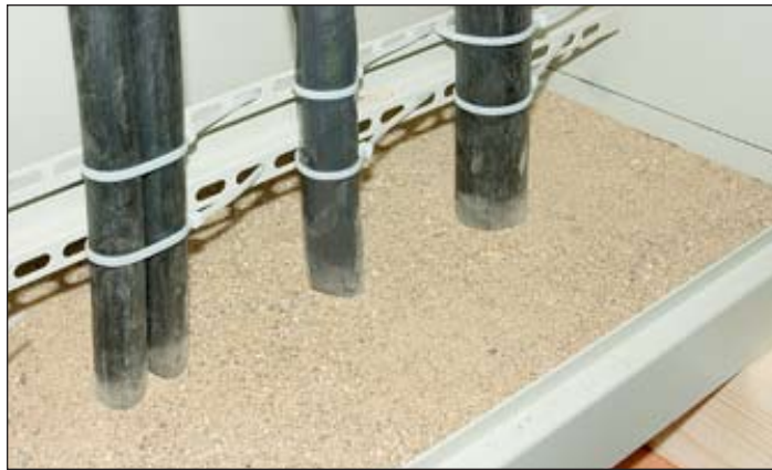
Рисунок 3.2 – Слой песка, насыпанный поверх шкафной доски
