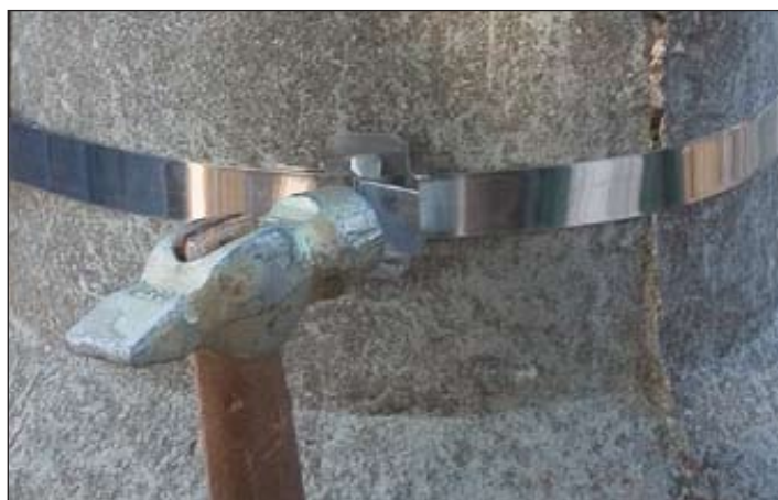
Рисунок 5.2 - Подбивание ленты и зажимов замка для хомутов
