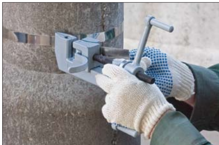
Рисунок 5.1 - Натяжение ленты с помощью клещей
