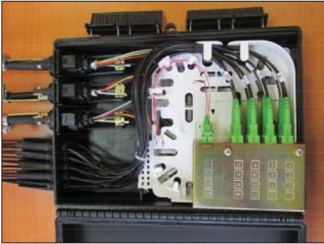
Рисунок А1 – Общий вид смонтированной муфты-красса с максимально возможным количеством введенных ОК
