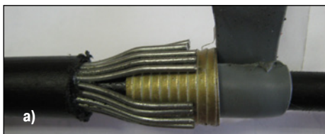
5.5 Разрезать пластину ленты мастичной вдоль на две части. Поочередно намотать ленту мастичную на внутреннюю оболочку ОК возле конуса, заводя витки ленты под конус (рисунок “а”).
