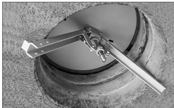
Рисунок 4.2 – Блокировка рычагов УЗНК относительно конструктивных элементов колодца
