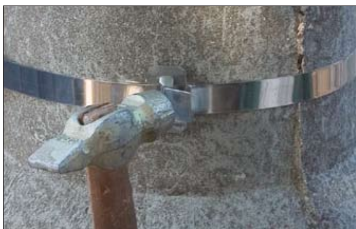
Рисунок 5.2 - Подбивание ленты и зажимов замка для хомутов
