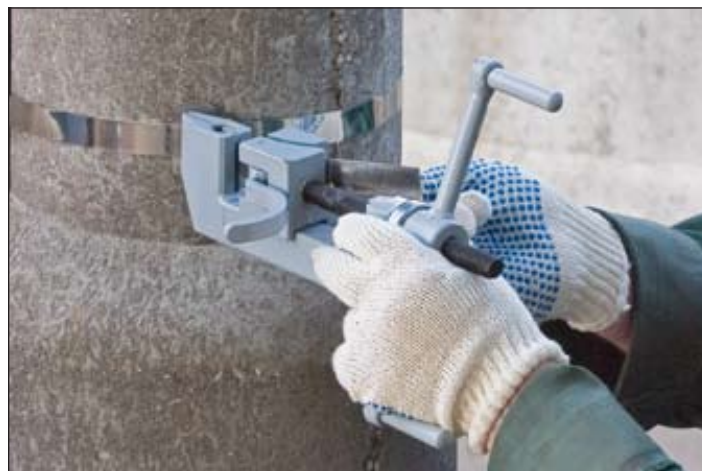
Рисунок 5.1 - Натяжение ленты с помощью клещей
