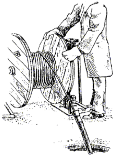
Рис. 7. Установка устройства для размотки оптического кабеля
