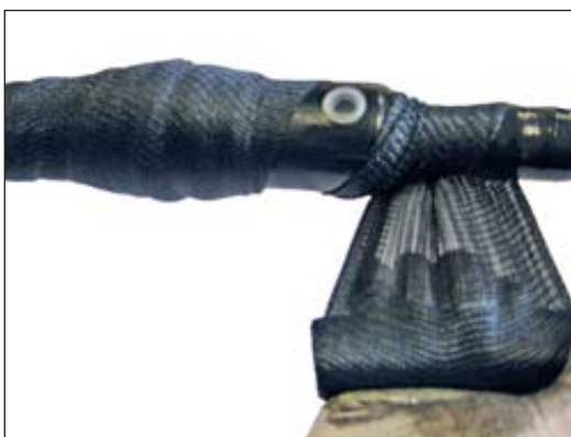
Рисунок 3.12 – Намотка бинта Армопласта (Armorcast)
