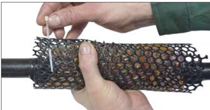
Рисунок 3.5 – Установка сетки на сrostок и крепление стяжками
