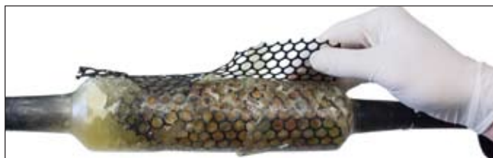
Рисунок 4.2 – Снятие сетки со сростка
