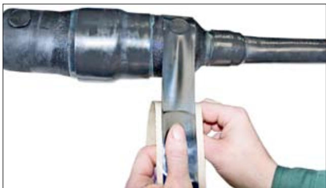
Рисунок 3.17 – Наложение ленты VM поверх пробок
