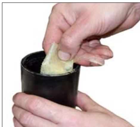
Рисунок 3.1 – Смазка внутренних поверхностей корпусов муфты гидрофобным наполнителем кабеля
