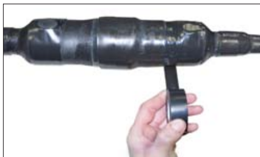
Рисунок 3.18 – Наложение ленты 88Т поверх ленты VM
