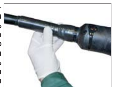
Рисунок 3.15 – Выпуск воздуха из корпуса муфты
