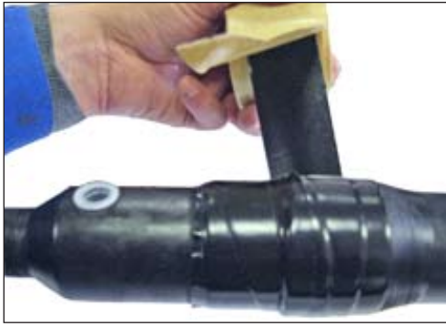
Рисунок 3.10 - Намотка ленты VM на стыке корпусов муфты
