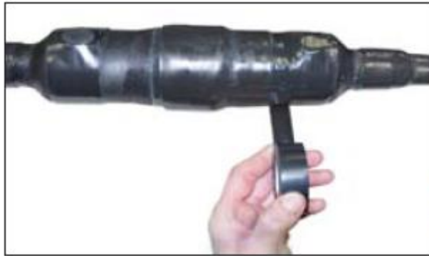
Рис. 12. Наложение ленты 88Т поверх ленты VM.
