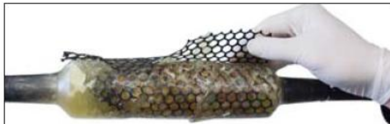
Рис. 15. Снятие сетки со сростка МГПг.
