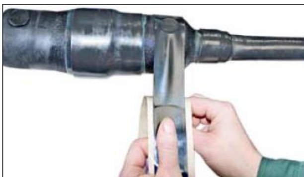
Рис. 11. Наложение ленты VM на отверстия, закрытые пробками.
