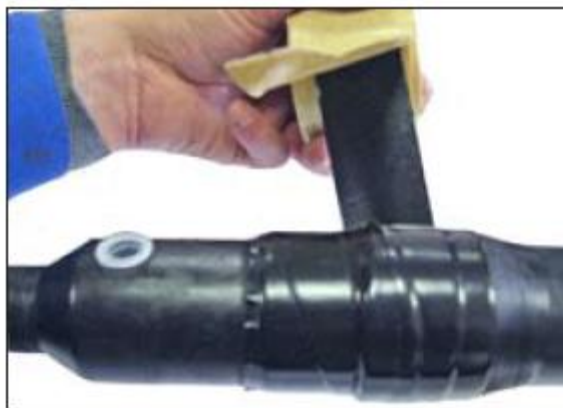
Рис. 19.Намотка ленты VM на стык полумуфт.
