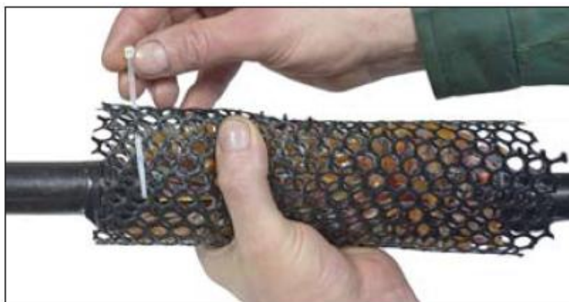
Рис. 4. Установка сетки на сросток и крепление её стяжками.
