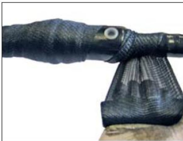
Рис. 21.Намотка бинта Армопласт (Armorcast).
