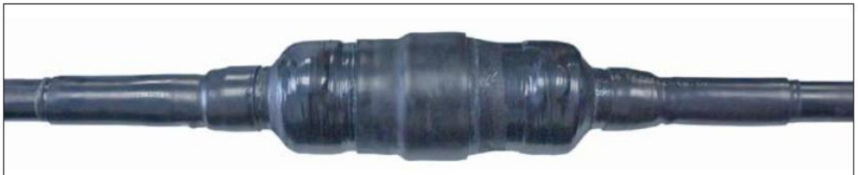
Рис. 13. Полностью смонтированная муфта МГПг.
