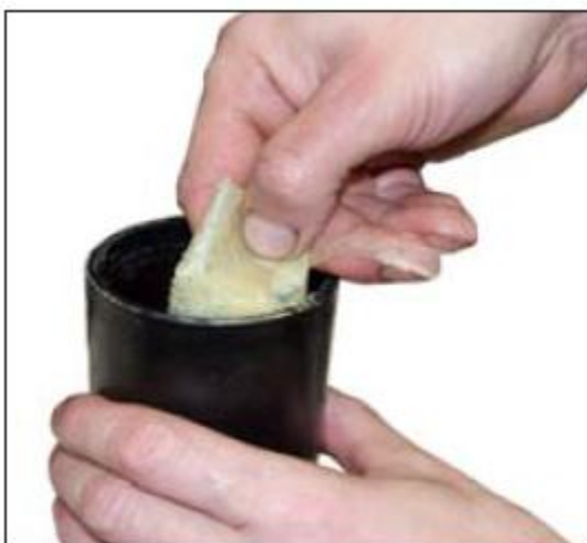
Рис. 1. Смазка внутренних поверхностей гидрофобным наполнителем кабеля.
