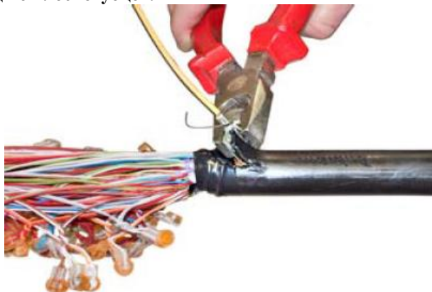
Рис. 5.Сжатие зажима с помощью плоскогубцев.
