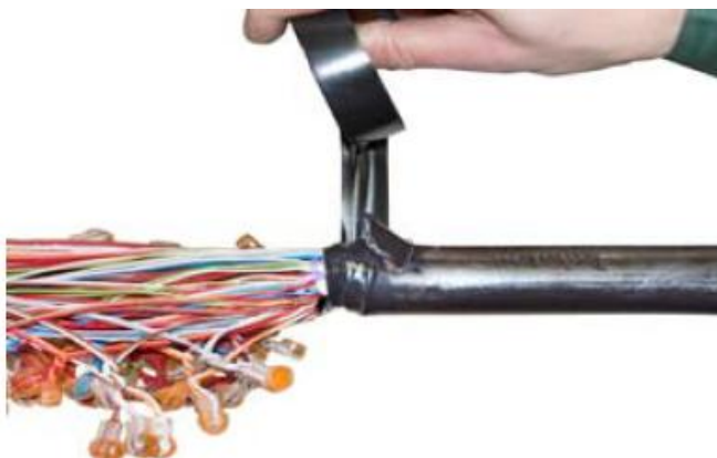
Рис. 3.Наложение бандажа под лепестком.
