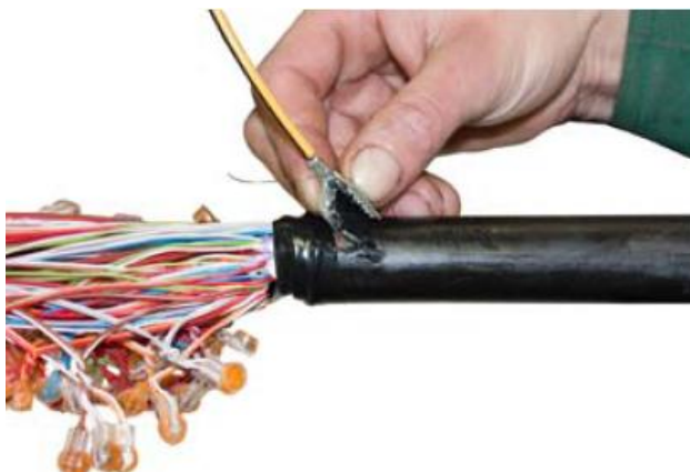
Рис. 4.Установка зажима ПСЭ на «лепесток».
