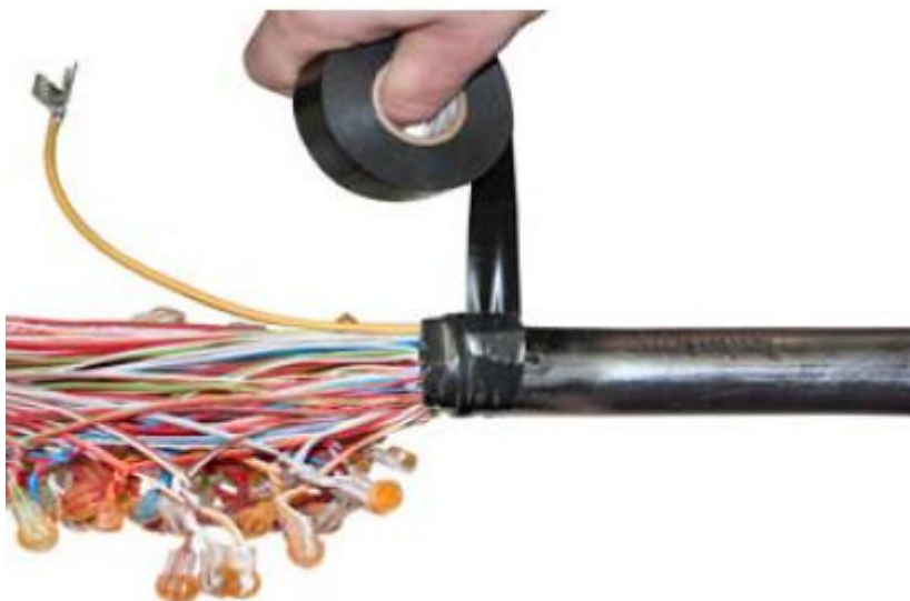
Рис. 6. Наложения бандажа на зажим и оболочку кабеля.
